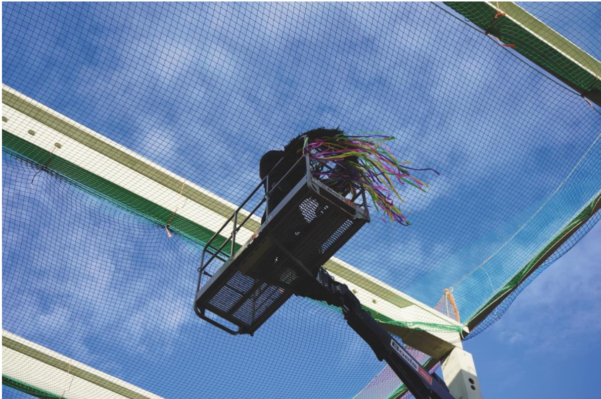
Richtfest der NOVO-TECH Circular GmbH & Co. KG im Industriegebiet Zornitzer Weg in Aschersleben
